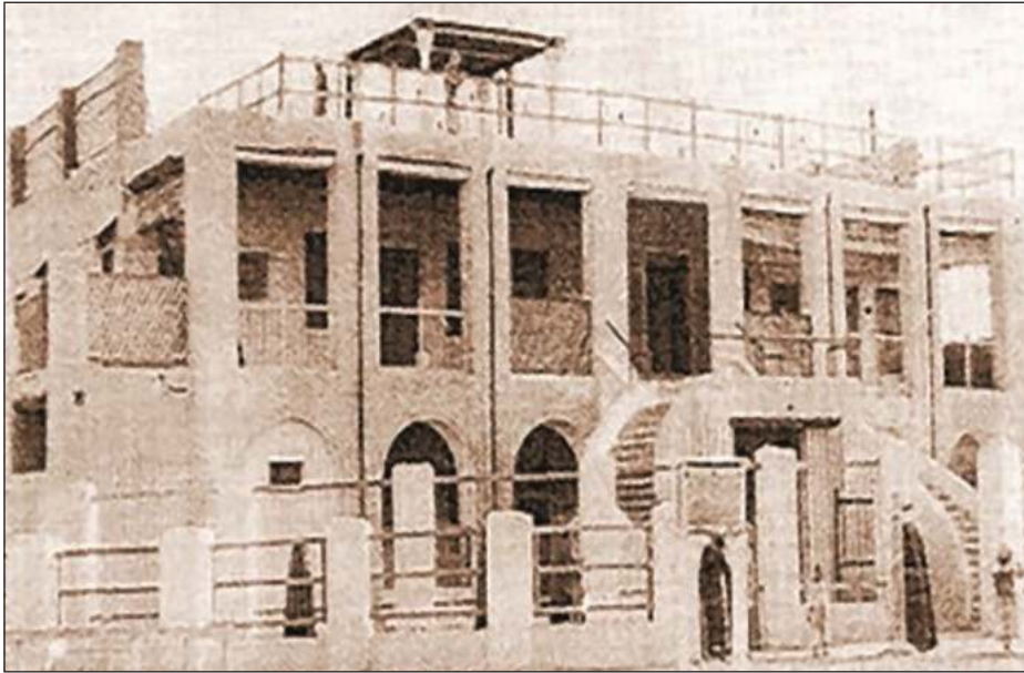
● مبنى البرق والهاتف
